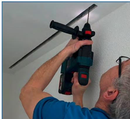
**5** Bohrlöcher für das Einlegeprofil markieren und anschliessend für die Montage bohren.
