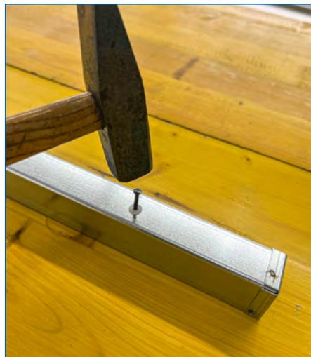
**5** Die mitgelieferten Stahlnägel und Kunststoffscheiben durch den Grundkanal treiben und Montage abschliessen.
