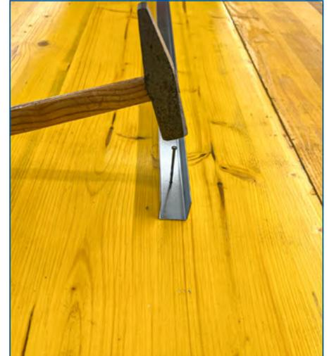
**3** Das Grundprofil kann mit normalen Nägeln auf die Betonschalung genagelt werden.
