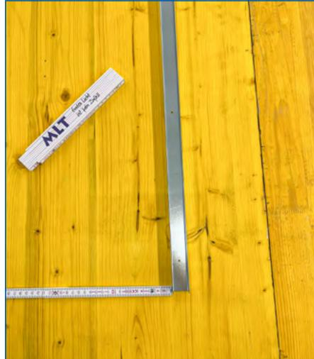
**2** Das Grundprofil wird eingemessen und anschliessend auf die Betonschalung genagelt.
