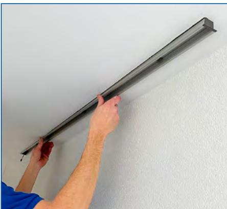
**7** Das Einlegeprofil in die Aussparung einpassen
