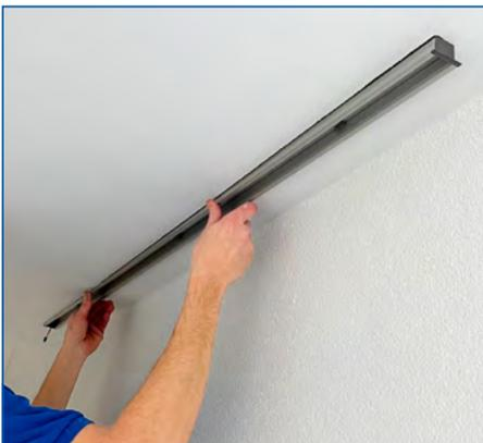
**4** Das Einlegeprofil in die Aussparung einpassen
