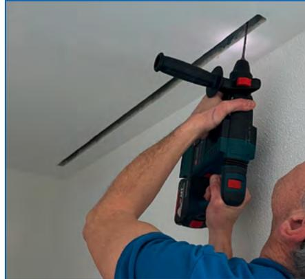
**2** Bohrlöcher für das Einlegeprofil markieren und anschliessend für die Montage bohren.
