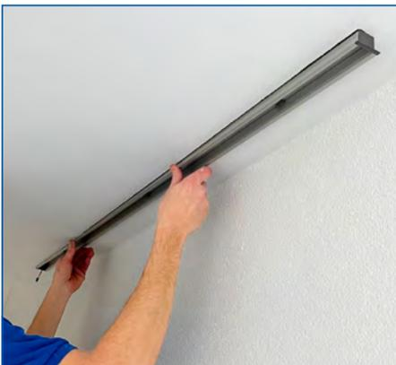
**4** Das Einlegeprofil in die Aussparung einpassen
